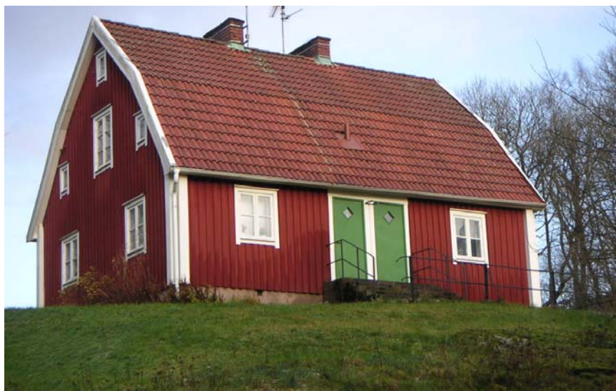
Sågarebostaden som den såg ut före senaste restaureringen då bl.a. skorstenar har åtgärdats och en luftvärmepump har installerats.
