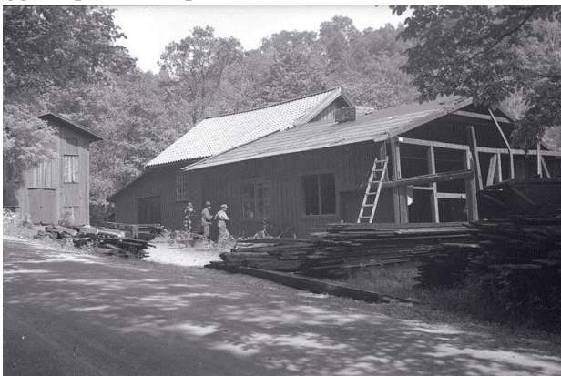
Bild på smedjan i samband med att den rivs på 1930-talet. Foto: Selma Sahlberg
