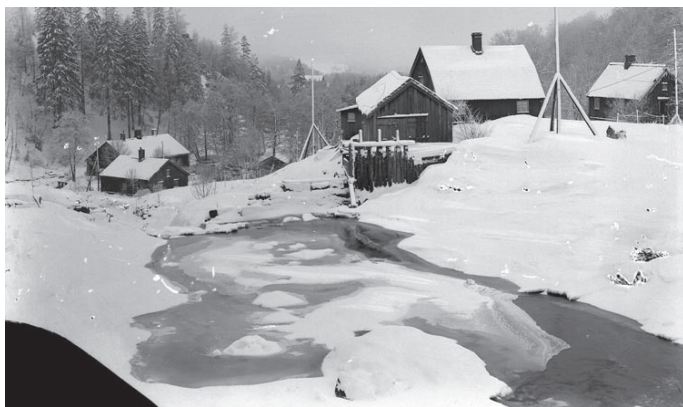
Såghuset och sågarbostaden. Såghuset i mitten tillkom omkring 1853
