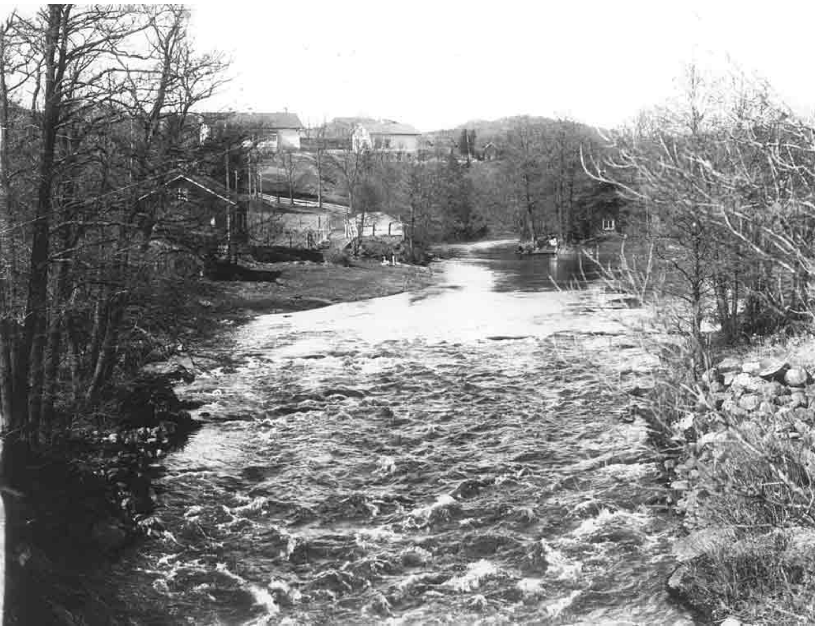
Lycke med sina båda skolbyggnader syntes väl en gång i tiden nerifrån Stenbron. Här syns herrgårdens tvättstuga till höger. Huset närmast till vänster är det gamla färgeriet som gett vägen dess nuvarande namn.
