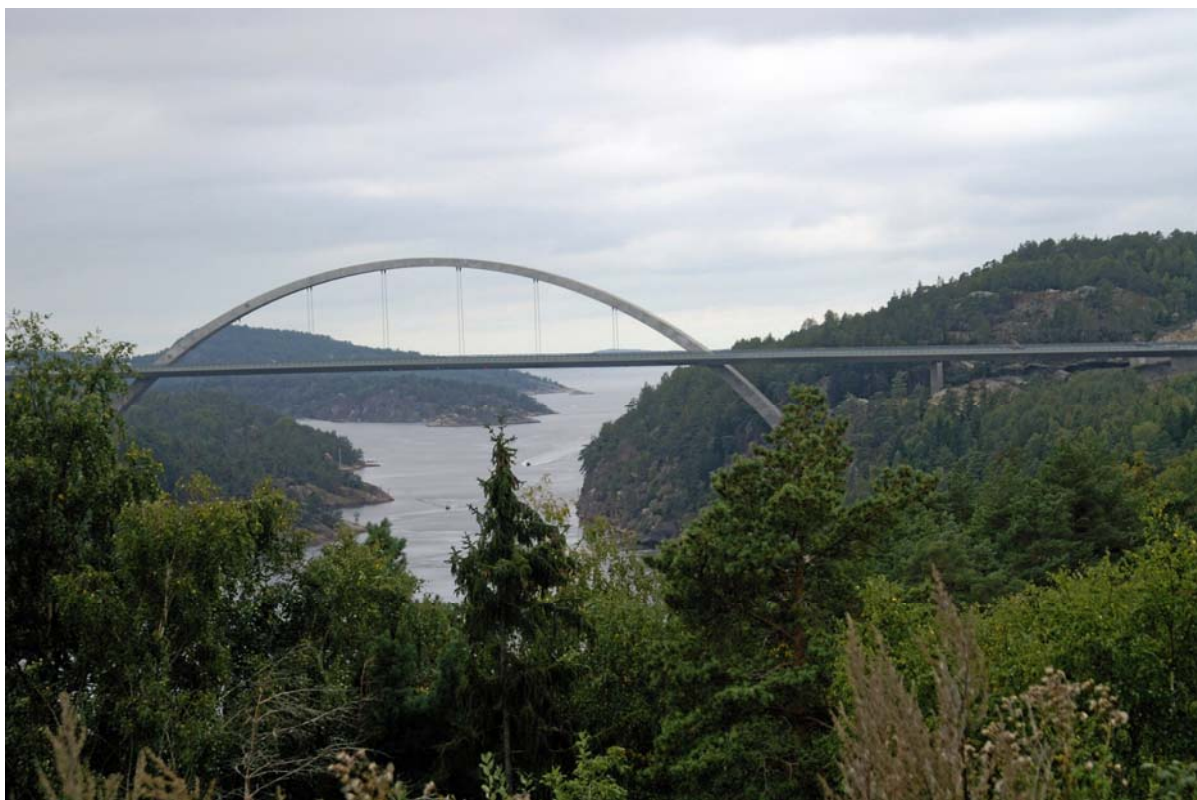
Utsikt mot nya Svinesundsbron från den gamla bron.
